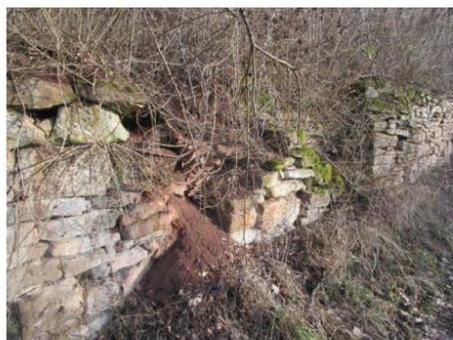
**Abb. 5: Herausgebrochene Mauerteile**
