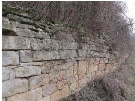
**Abb. 3: Mauerabschnitt mit Ausbuchtung**
