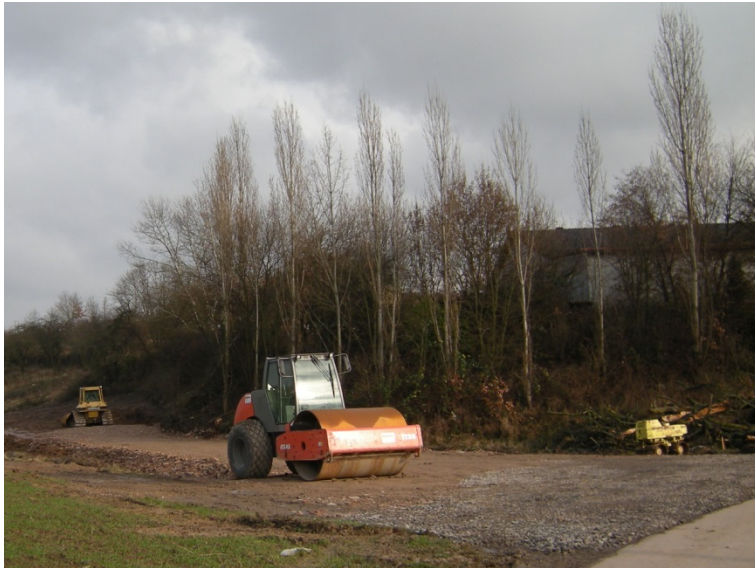
Abbildung 4: Auffüllung mit noch bestehenden Pappeln im Hintergrund
