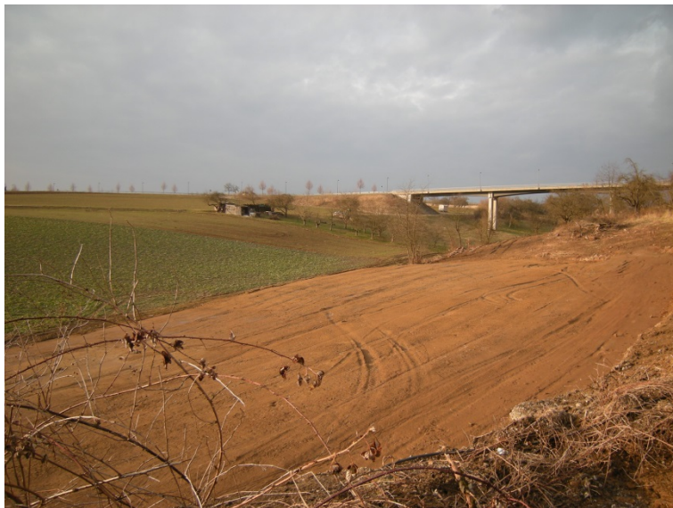
Abbildung 5: Fläche mit abgeschobener Vegetation
