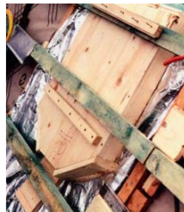
Abb. 20: Integration eines Fledermauskastens unter der Dachhaut 3
