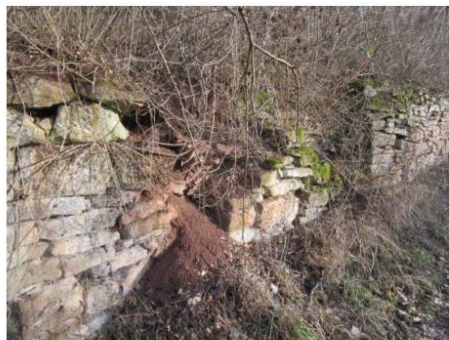
Abb. 5: Herausgebrochene Mauerteile
