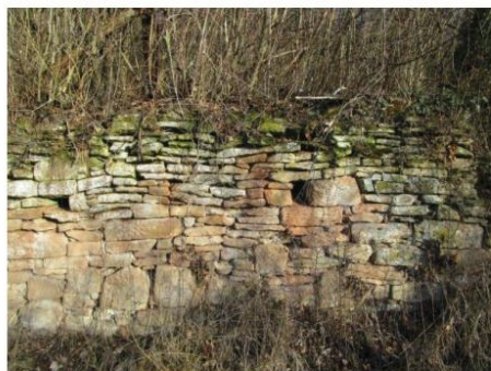
Abb. 7: Schmale, brüchige Mauersteine
