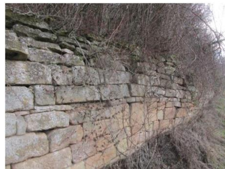
Abb. 3: Mauerabschnitt mit Ausbuchtung
