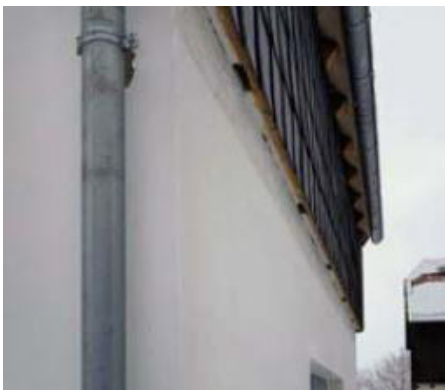
Abb. 21: Spaltenquartiere hinter Schieferverkleidung 4
