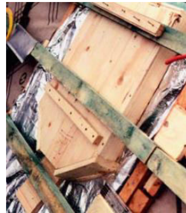
Abb. 20: Integration eines Fledermauskastens unter der Dachhaut 3
