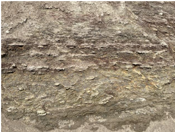
Abb. 4: Steile Wand der Baugrube ohne jegliche Versteckmöglichkeiten für Tiere.
