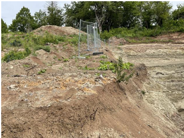
Abb. 8: Übergangsbereich zwischen Baugrube und Bodensenke mit Ruderalvegetation.
