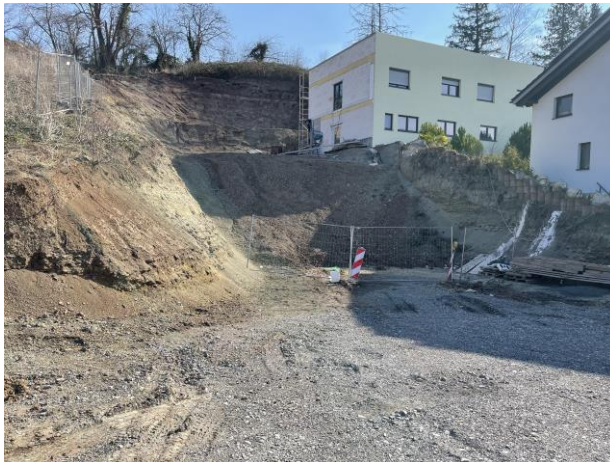
Abb. 2: Blick auf die Baugrube mit südlich angren- zender Bebauung von der Seestraße aus.
