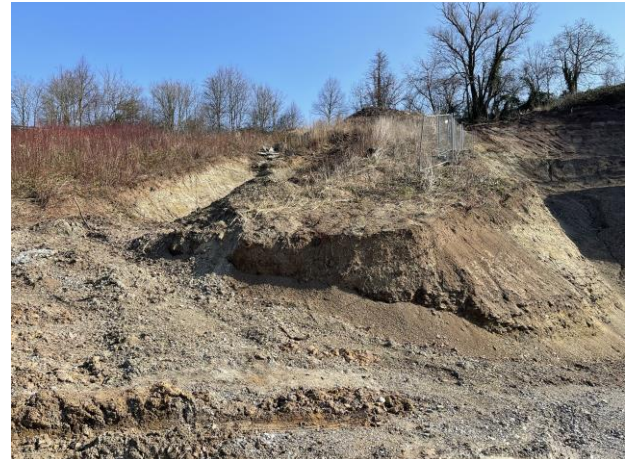
Abb. 7: Übergangsbereich zwischen Baugrube und Bodensenke mit Ruderalvegetation.
