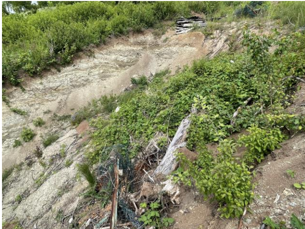
Abb. 6: Bodensenke mit Baumstamm, Müll und Pioniergehölz nördlich des Plangebiets.
