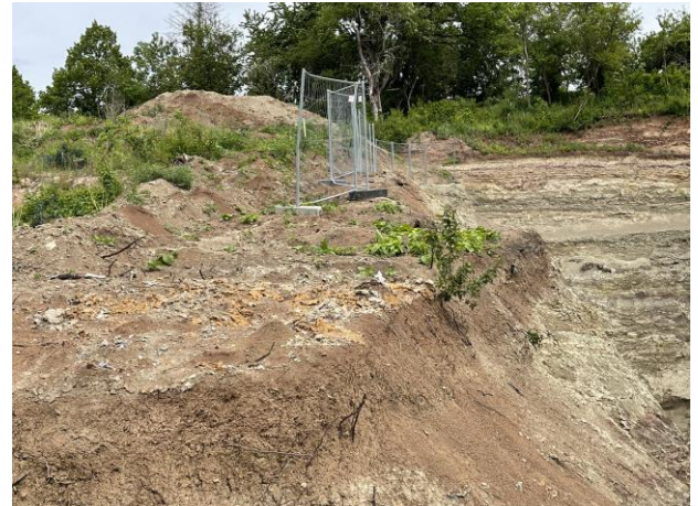
Abb. 7: Übergangsbereich zwischen Baugrube und Bodensenke mit Ruderalvegetation.
